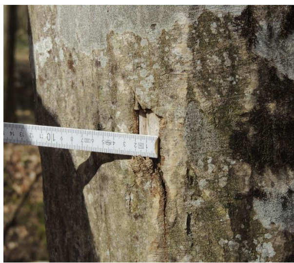
Slika 6.74 Izmjera dimenzija oštećenja
